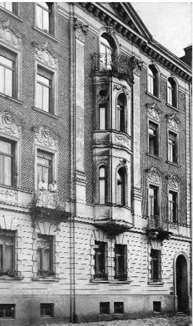
Franz-Joseph-Str. 2, 1910. Der heutige Neubau trägt zwei Kunsttafeln, die an die Manns und den alten Bau erinnern.
