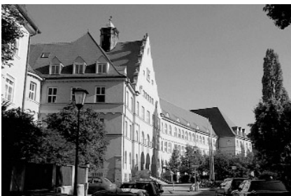
Abb. 2.3.4.1 Das Maximiliansgymnasium ist eines von 1.000 Gebäuden, die untersucht wurden
