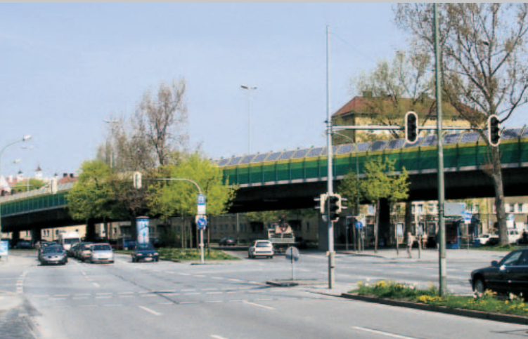
Simulation: Candidbrücke – integrierte Photovoltaikanlage in der Lärmschutzwand.
