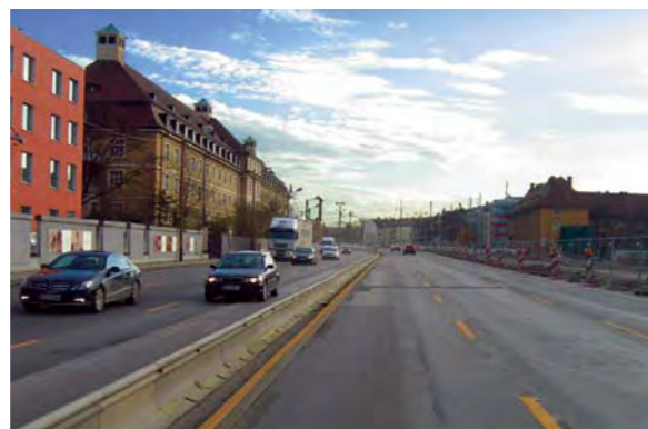
Trotz Baustelle stehen dem Verkehr in der Garmischer Straße drei Spuren pro Fahrtrichtung zur Verfügung.
