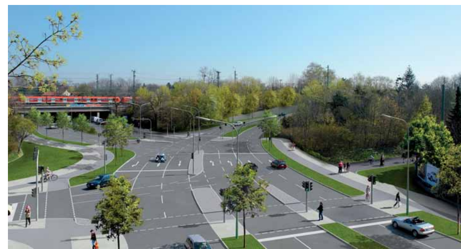
Knoten Lortzing-/Kafler-/Haberlandstraße, Blick nach Norden
