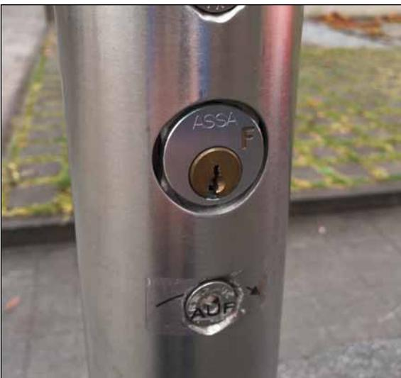
Bei der Branddirektion München ist ein „Münchner Feuerwehrschießsystem“ eingeführt worden. Dieses Schließsystem kann in Zugänge, Tore, Schranken und Sperrpfosten von Feuerwehzufahrten, für Feuerwehraufzugsteuerungen, als Zugangsmöglichkeit für Aufzugmaschinenräume, Aufzugkabinenerweiterungen, Technik,- und Sprinklerräume u. ä. als Profilzylinder oder Profilhalbzylinder eingebaut werden.
