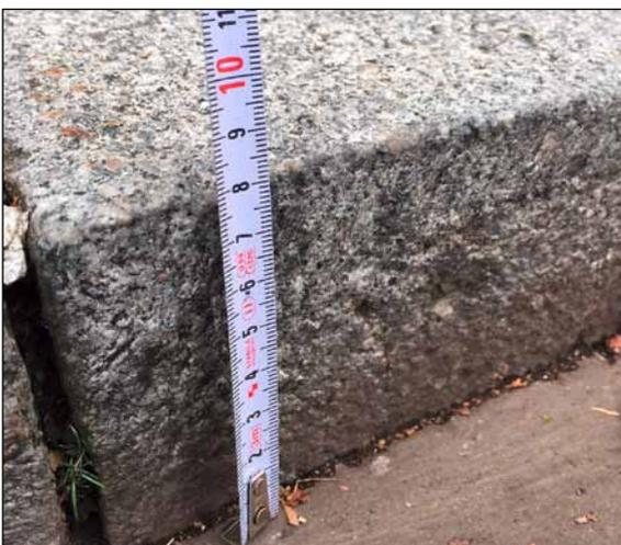
Die maximal zulässige Höhe des abgesenkten Bereichs darf im Sinne des Punkts III.6 (Stufen und Schwellen) 8 cm nicht überschreiten. Die Bordsteinabsenkung muss im Vergleich zum angrenzenden Bordstein für den Verkehrsteilnehmer **deutlich erkennbar** sein.
