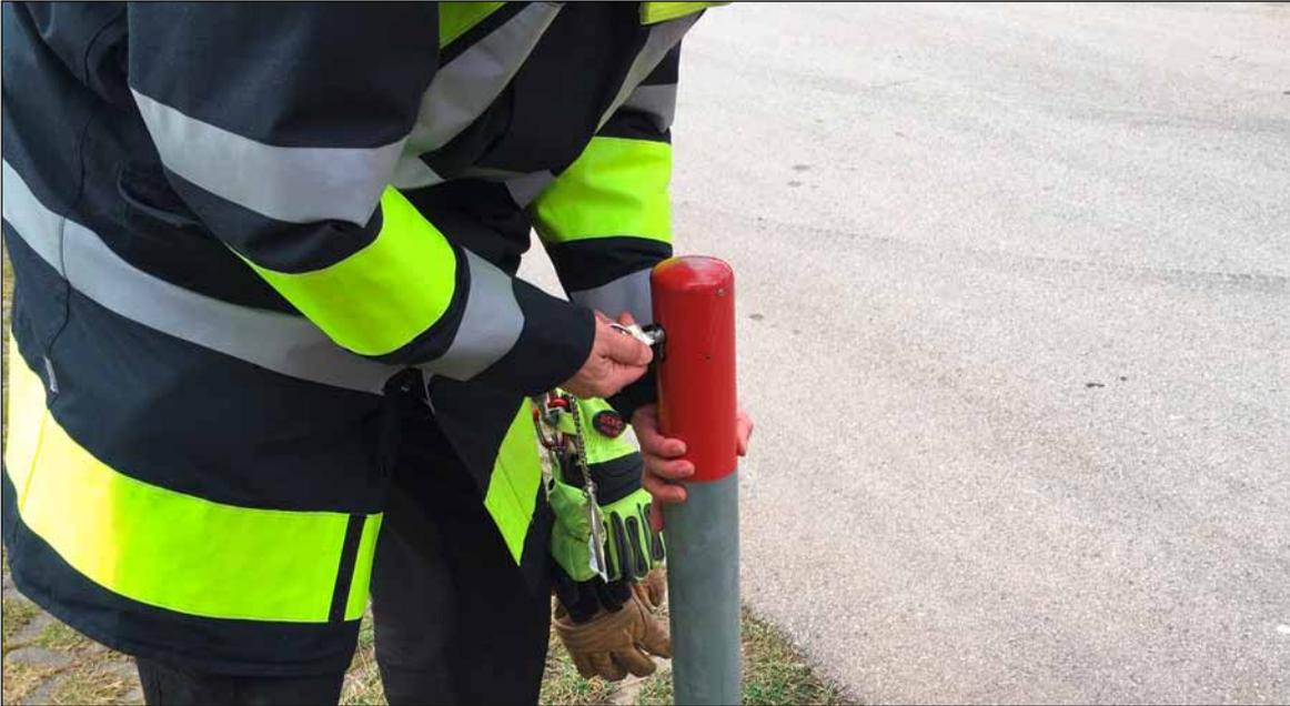
Sperrpfosten mit F-Schließung - eingebaut in einem Sperrpfosten vor einer Feuerwehzufahrt
