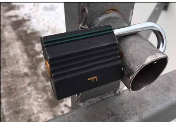
Die zur Sicherung von Feuerwehzufahrten oft verwendete Verschlusseinrichtung nach DIN 14925 kann von Unbefugten relativ leicht geöffnet werden. Das „Münchner Feuerwehrschießsystem“ bietet den hohen Sicherheitsstandard üblicher Profilzylinder, denn nur Nutzungsberechtigte sind im Besitz von Schlüsseln.
