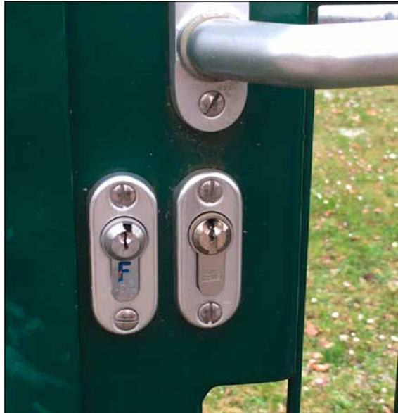
Zugangstor mit Tandemschließung. Entweder über den Schließanlage des Gebäudes oder durch die Feuerwehr öffnenbar
