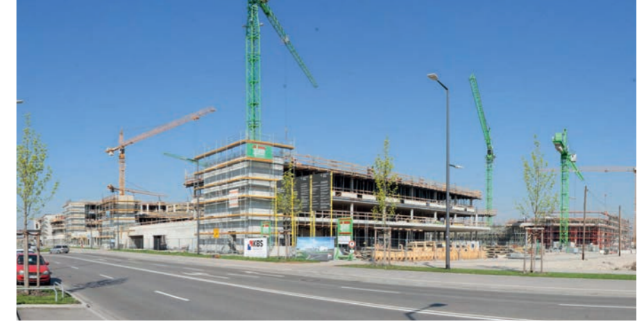
Baustelle im April 2018, Ansicht von der Bodenseestraße
