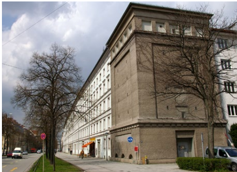
Wohnblock mit Bunkerturm in der Prinzregentenstraße, Aufnahme von 2009
