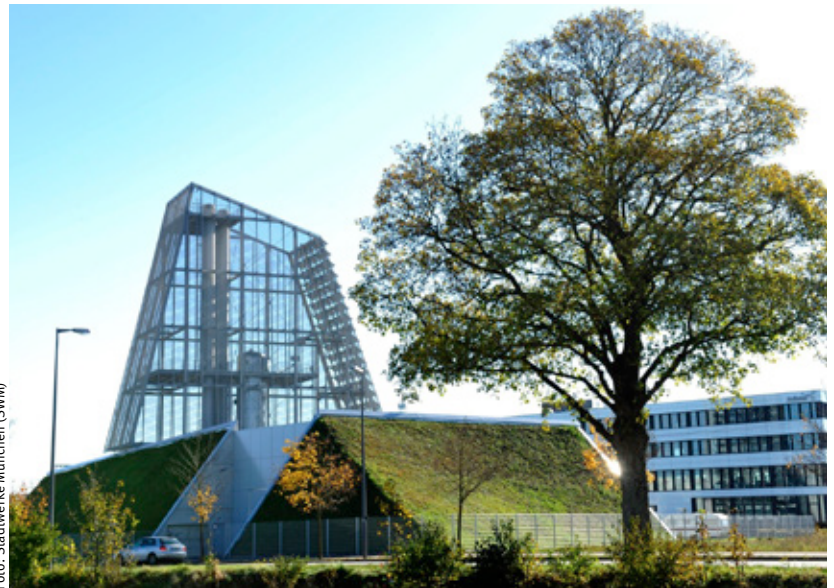
Foto: Stadtwerke München (SWM)
