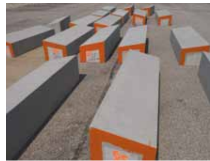
Stahlbetonfertigteile an den „Spielkisten“ vor und nach dem Einbau
