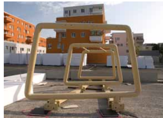
Einbau von Leichtbaumaterialien und Montage der Kletterdüne
