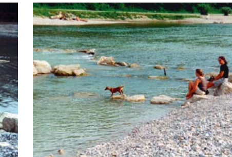
Nun ersetzen flach geneigte aufgelöste Sohlrampen die ehemaligen Sohlabstürze. Aus Becken und Blocksteinriegeln aufgebaut, erfüllen auch sie die notwendige sohlstützende Funktion. Sie sind aber für Fische und andere Gewässerorganismen durchwanderbar und zudem beliebter Aufenthaltsort für Erholungssuchende.
