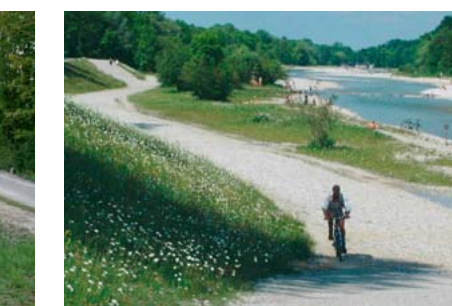
Die neuen Deiche sind ausreichend hoch und breit. Durch Deichvorschüttung konnten alte Alleebäume auf der Deichkrone erhalten bleiben. Auf den Böschungen entwickeln sich blütenreiche Magerrasen.
