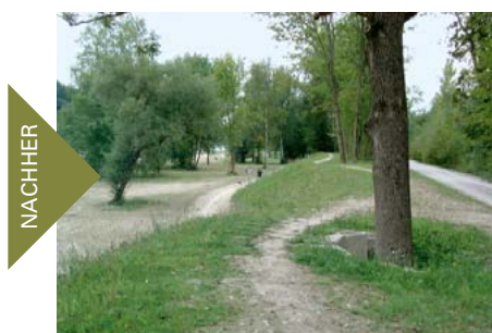
Die neuen Deiche sind ausreichend hoch und breit. Durch Deichvorschüttung konnten alte Alleebäume auf der Deichkrone erhalten bleiben. Auf den Böschungen entwickeln sich blütenreiche Magerrasen.
