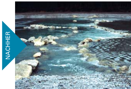
Nun ersetzen flach geneigte aufgelöste Sohlrampen die ehemaligen Sohlabstürze. Aus Becken und Blocksteinriegeln aufgebaut, erfüllen auch sie die notwendige sohlstützende Funktion. Sie sind aber für Fische und andere Gewässerorganismen durchwanderbar und zudem beliebter Aufenthaltsort für Erholungssuchende.
