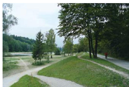
Deichvorschüttungen zur Erhaltung des vorhandenen Baumbestandes
