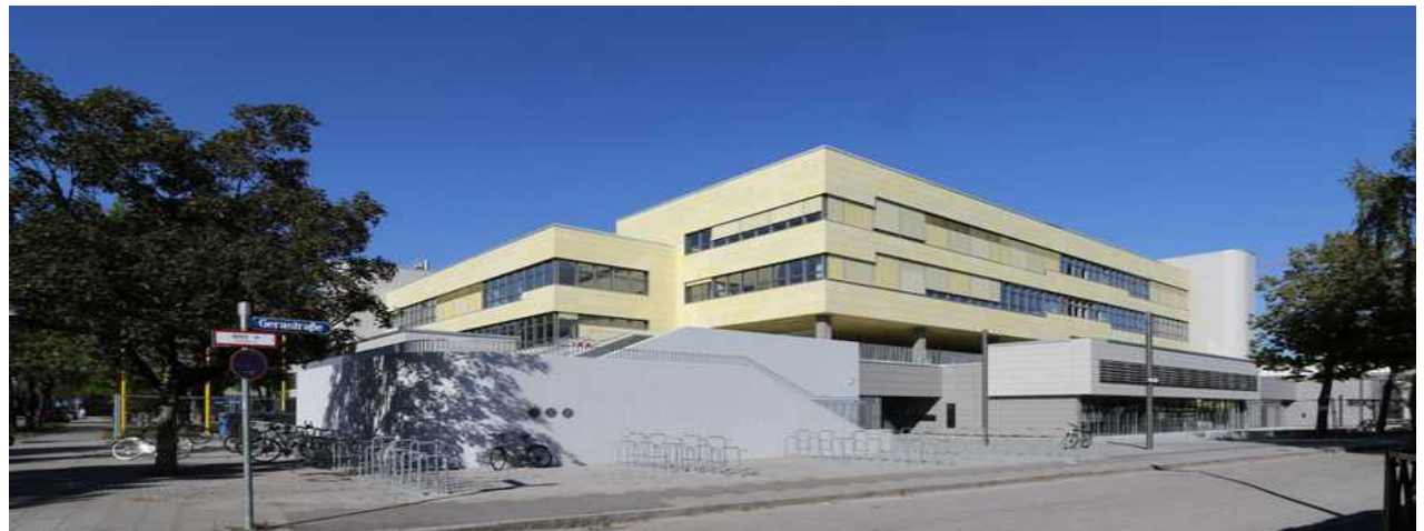
Schulzentrum Gerastraße (Foto: AKR)
