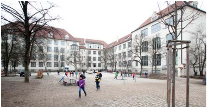
Grund- und Mittelschule an der Simmernstraße nach Sanierung
