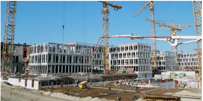
Wohnungsbau in München
