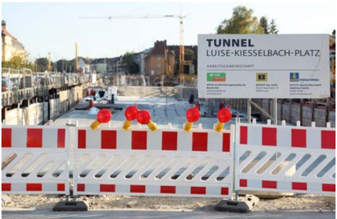
Baustelle am Luise-Kisselbach-Platz
