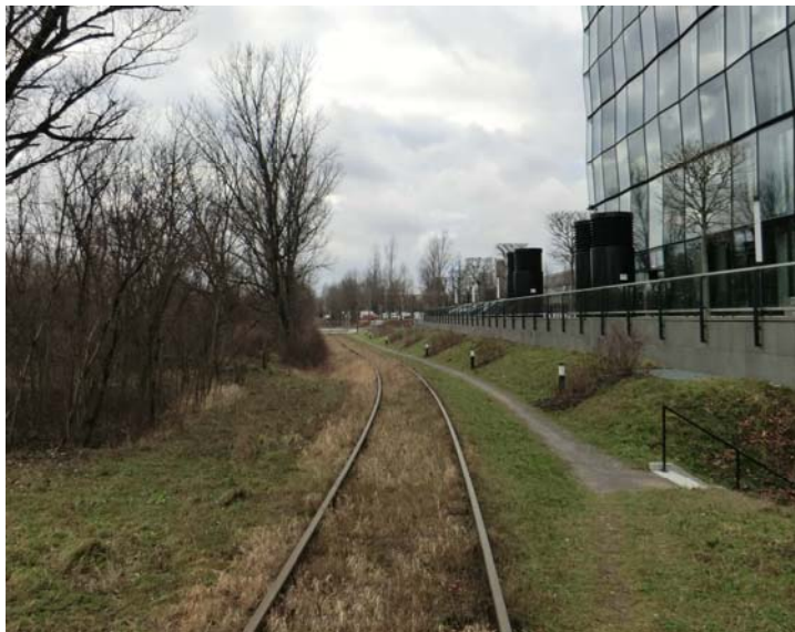
Bild 4: Anschlussgleis vor dem Süddeutschen Verlag
