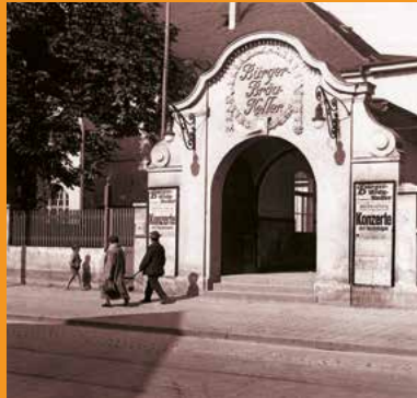
Eingang des Bürgerbräukellers an der Rosenheimer Straße, 1930er Jahre
