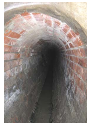
Zu sanierender Kanal aus Mauerwerk
