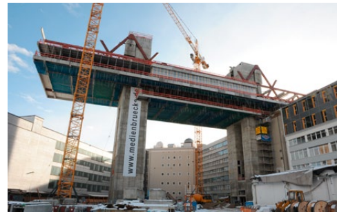
Bauarbeiten an der »Medienbrücke« im Hof der Rosenheimer Straße 145 im Dezember 2009
