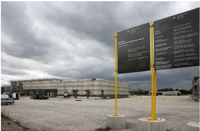
Bau des Schulzentrums an der Nordhaide
