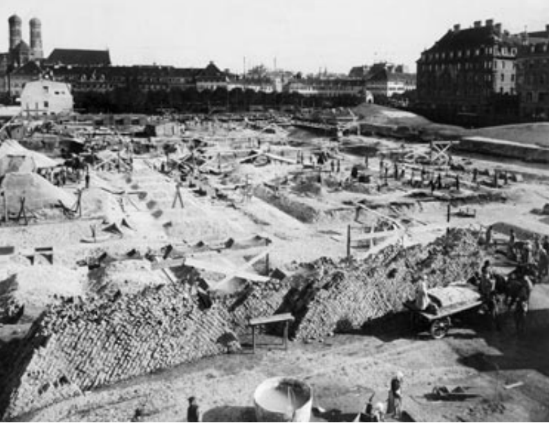
Baustelle des Justizpalastes am Münchner Stachus um 1890. Im Vordergrund lagern Ziegel in den damals typischen schrägen Stapeln.
