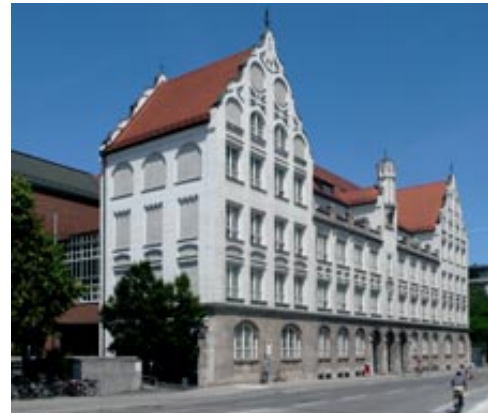
Am Gymnasium in der Luisenstraße sind weiß geschlammte Ziegel zur Fassadengestaltung eingesetzt. Aufnahme von 2011.
