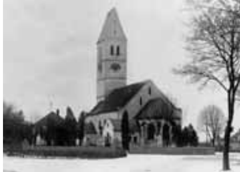
St. Peter und Paul um 1930. Von der Dorfkirche blieb nur der 37 Meter hohe Turm erhalten.
