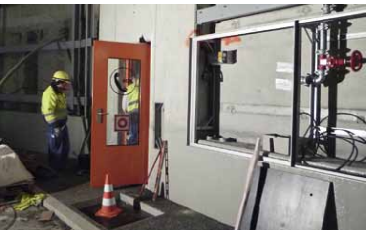
Genau aufeinander abgestimmt laufen die Arbeiten an der Tunnelverkleidung und der Installation der Ausstattung. Parallel zu den Montagearbeiten werden die Türen in der Mittelwand und zu den Notrufnischen gesetzt.
