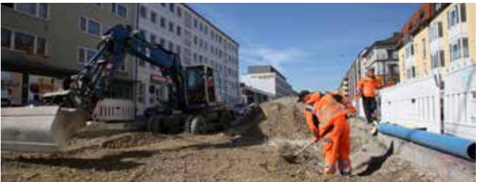
Bauarbeiten auf der Albert-Roßhaupter-Straße: Die Stadt entfernt die seit langem aufgelassene Trambahntrasse und schafft mehr Platz für Rad- und Gehwege sowie für Bäume am Straßenrand.
