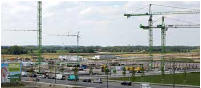
Blick auf die Baustelle des künftigen Bildungscampus in Freiham.
