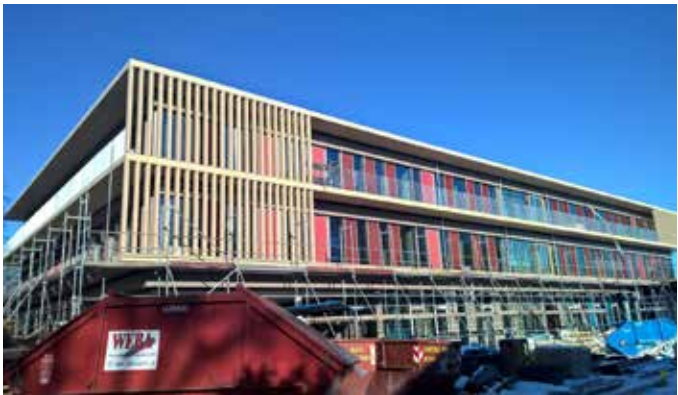
Neubau der Grundschule an der Grandlstraße. (Bild: Referat für Bildung und Sport)
