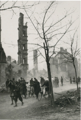
Während des Luftangriffes vom 24./25. April 1944 wurde auch die Mariahilfkirche zerstört.
