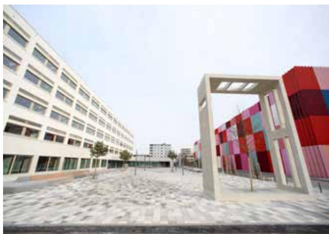
Das neue berufliche Schulzentrum an der Nordhaide wurde im September 2016 fertig gestellt.
