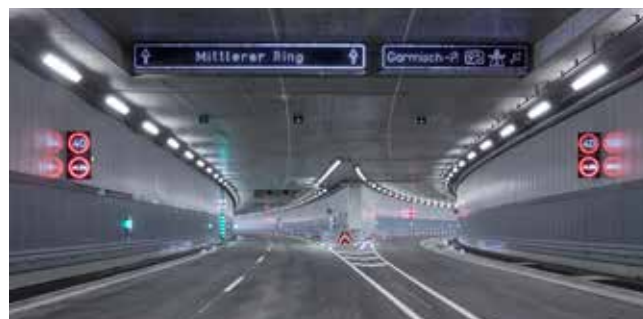
Nach rund sechsjähriger Bauzeit ist der Luise-Kiesselbach-Tunnel seit dem 25. Juli 2015 für den Verkehr geöffnet. Quelle: Jens Weber, München
