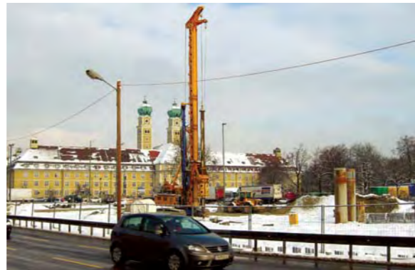
Auch bei winterlichen Wetterverhältnissen laufen die Arbeiten weiter.
