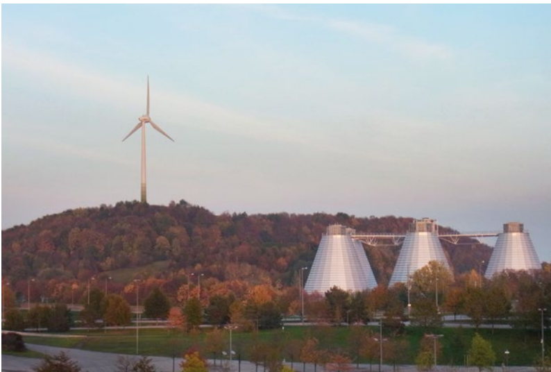
Windkrafttrad und Faultürme am Fröttmaninger Berg
